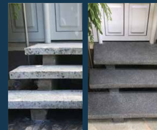
vorher Treppensanierung nachher
