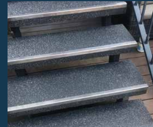
Treppenbeschichtung inkl. Verblendung
