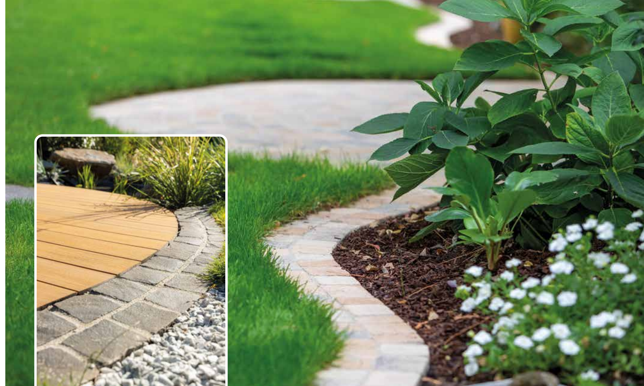
doppelreihige verfugte Einfassung
